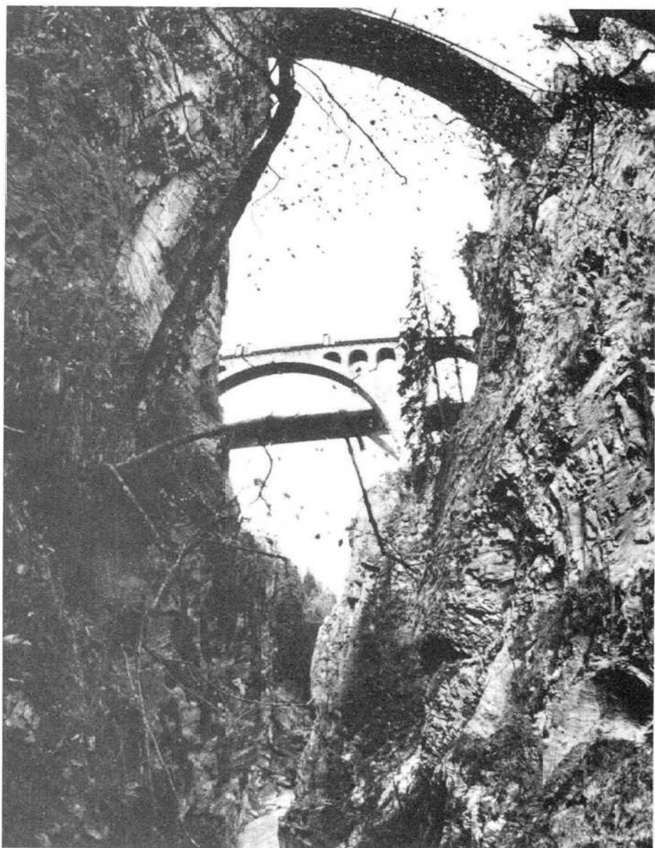
3 punts sur la chavorgia a Solis: d'avant la punt da la via veglia dal Schyn, immez il viaduct da la Vialfiera Retica (1901/02) e davous la punt da la via nova (1972).
