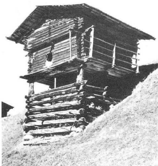
In baghetg cun talina ch'ei construius en ina plaunca feig teissa
