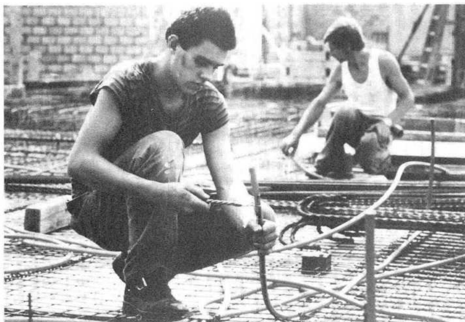
Installaziun digls beischels da schurmetg
