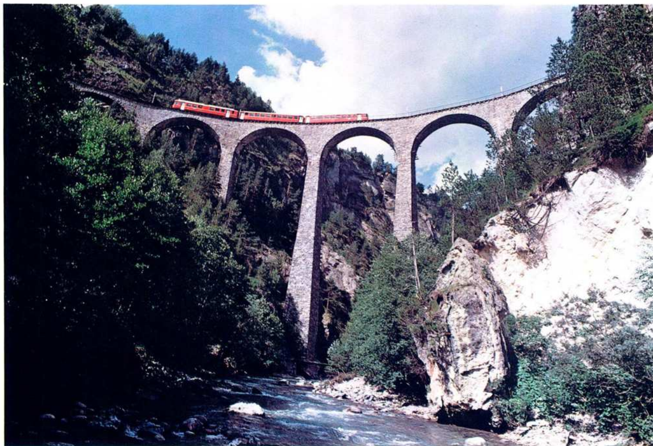
Igl imposant viaduct dalla Landwasser traversescha la val cun ena stierta da 100 m radius.
