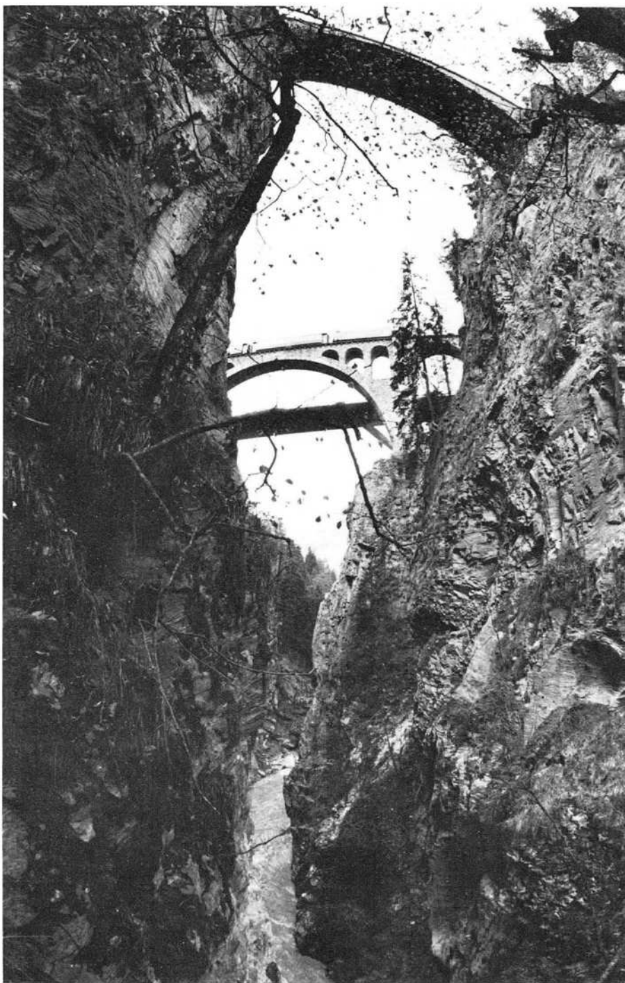
Oz èn treis punts a Solis l'egna dasper l'otra. Ellas stattan an buna armuneia l'egna sper l'otra. Davant è la punt dalla veia digl Schin, an mez è igl viaduct dalla veiadafier, biagia 1901/02 cun en tratg da ladezza da 42 m e la terza è la punt nova dalla veia biageida 1972, lunghezza 78 m.
