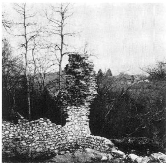
Restonzas dil casti de Chischlatsch della cantunada enviers sidost.
