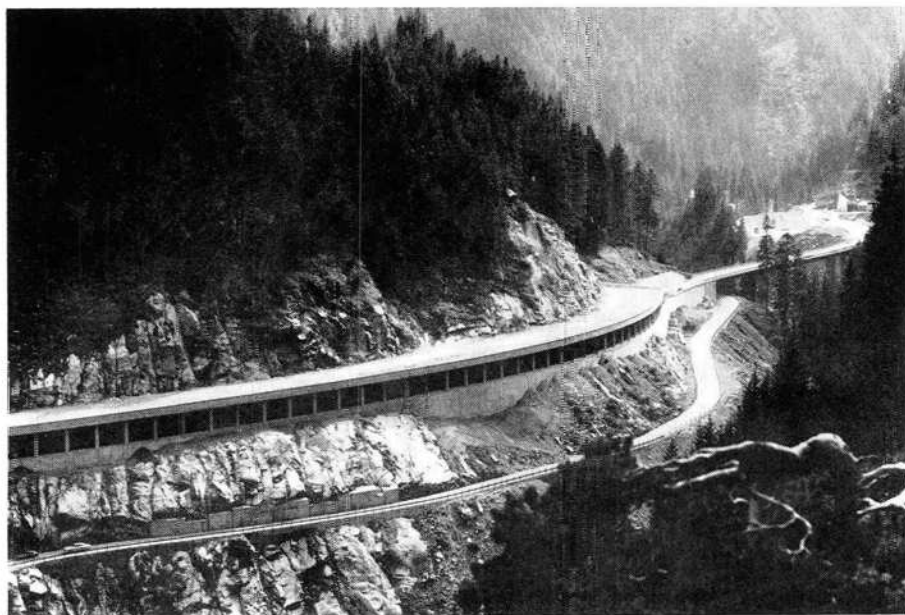
Galleria della Roffla. Sutvi la veglia via locala, plinensi la Punt della Roffla e sisum il portal dil Tunnel della Roffla. La galleria ei baghegiada per il schurmetg encunter curdadas de crap-pa en quei territori sfendiglius de carpam e greppam depositari. (Foto Uffeci de construcziun bassa: Cramer)
