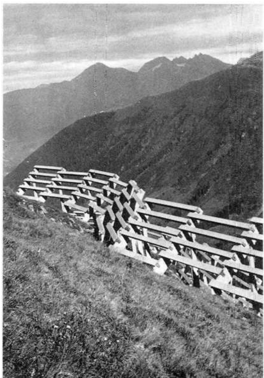
Foto 3 Lavineras de beton armau a Milez — Sin ils purtaders encrenai vesein nus las tromas de beton armau. La lavinera principala cun 5 tromas e la lavinera ligionta cun 4 tromas.
