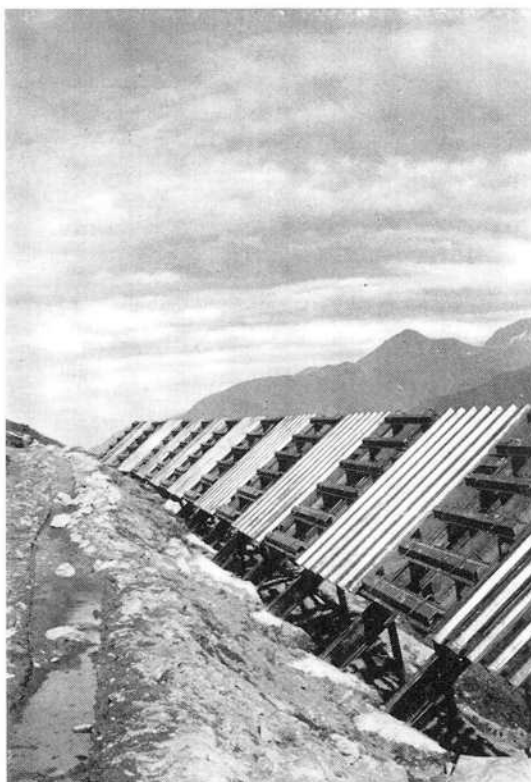
Foto 8 — Il maletg muossa co punts e ristials sebratan harmonicamein e datten in maletg zun plascheivel. Dretg vesein nus la terrassa, la quala survescha per transportar neutier il material. (Emprema rietscha lavineras de quei fabricat montadas la stad 1969)
