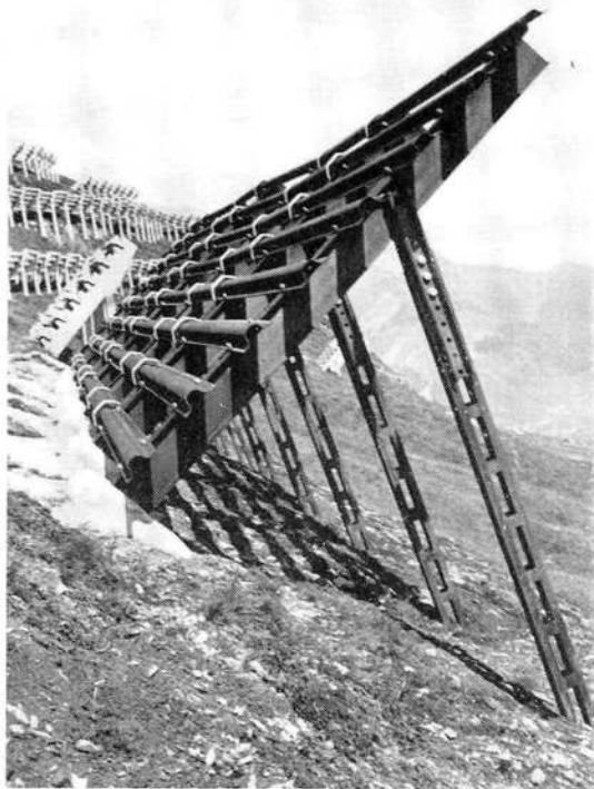
Foto 5 Punt de neiv — Dalla vart vesein nus la punt de neiv tip D = 3.50 m cun 8 travs horizontalas. La cruna de beton dils fundaments dils purtaders ei veseivla. La lavinera ligionta ei fermada cun fermes artgs de fier vid la lavinera principala. El fons dil maletg vesein nus enzacontas rietschas lavineras de beton.
