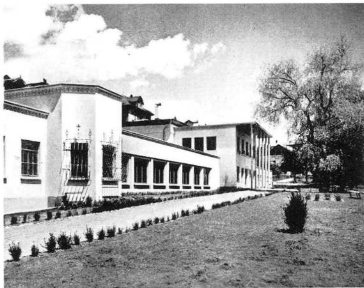
Stabilimaint da bagns.
